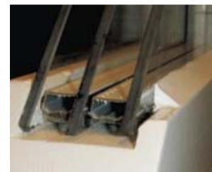
Snitt av spacer og kittfals
